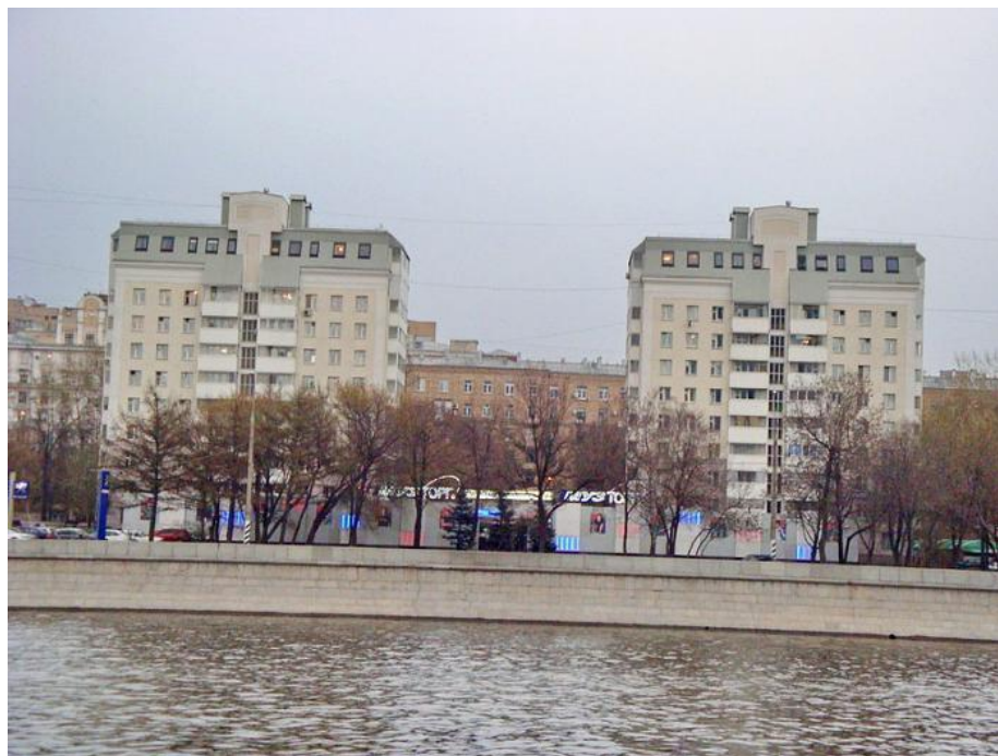
Рисунок 4.14 - Жилые дома 3 и 5/9 после санации по ул. Краснохолмской набережной г. Москва
