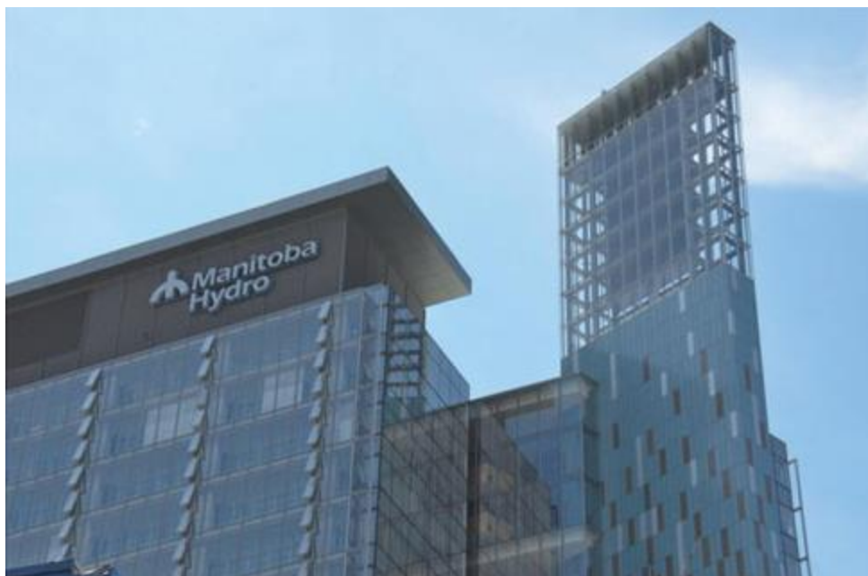
Рисунок 4.1 - Фасадные системы, использующие энергетический потенциал солнца. Manitoba Hydro Place (Виннипег, Канада)
