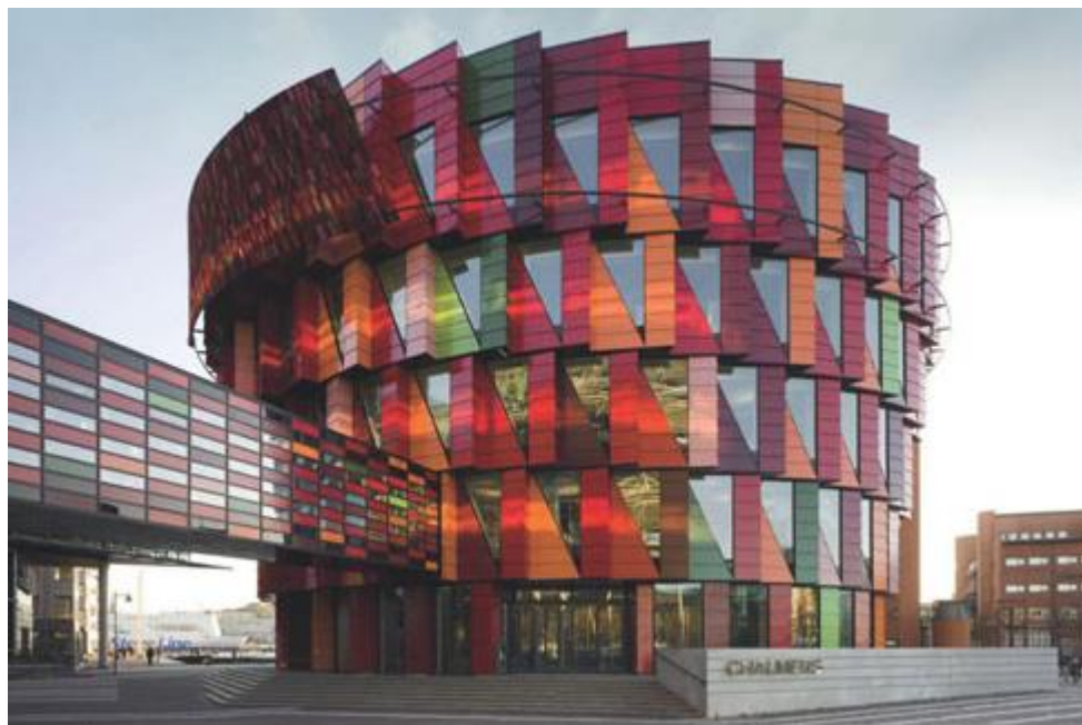
Рисунок 4.2 - Биоклиматическое здание с кинетическими климатически адаптивными фасадами. Kuggen Технический университет Чалмерса (Гетеборг, Швеция)
