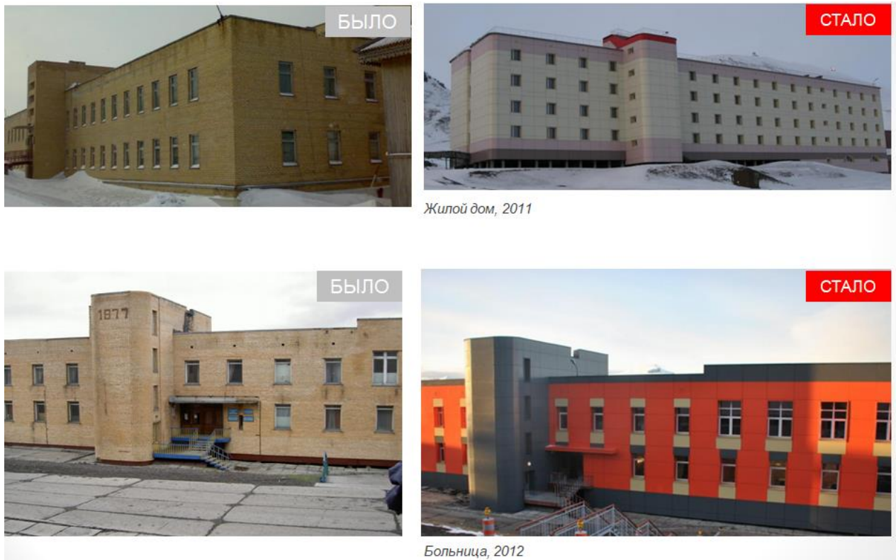
Рисунок 4.9 - Утепление фасадов зданий г. Баренцбург
